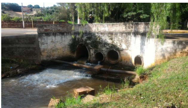
Foto 6.15 – Córrego Rangel e Ponte da Rua Francisca Bigarato - Jusante
