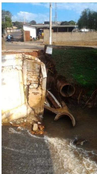
Foto 6.11 – Tubulação da galeria de águas pluviais que encaminha para o Córrego Rangel
