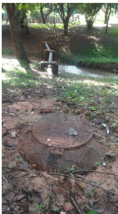
Foto 6.18 – Poço de Visita da Sabesp e tubulação de esgoto que passa pelo Córrego
