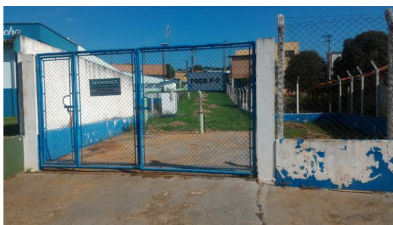
Foto 6.1 – Localização - Poço Profundo (P2)
