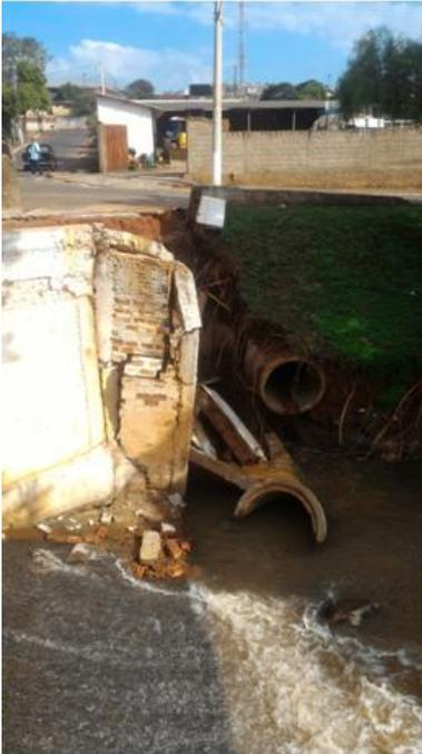
**Foto 3.11 – Tubulação da galeria de águas pluviais que encaminha para o Córrego Rangel**
