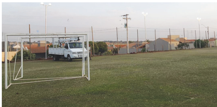
Refletores foram instalados no campo do CAS
