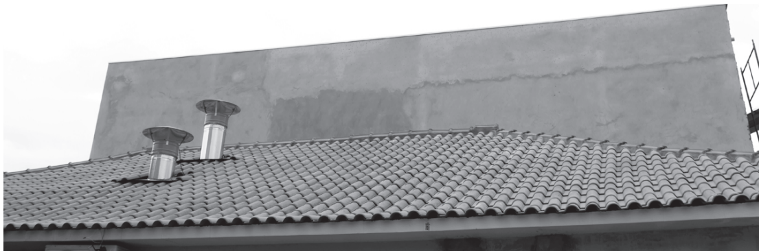
Central de esterilização de materiais teve o telhado trocado
