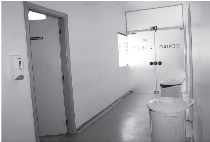
Centro Cirúrgico ganhará novos vestiários
