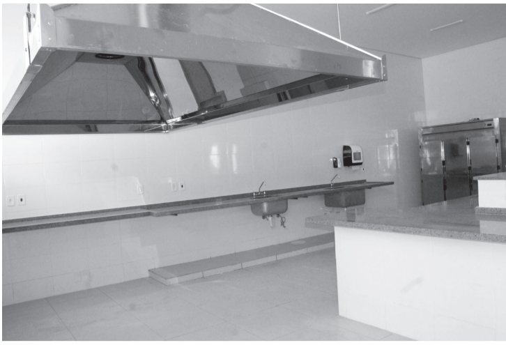
Reforma da cozinha está na fase final
