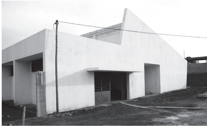
Hoje a obra atinge 90% de sua construção
