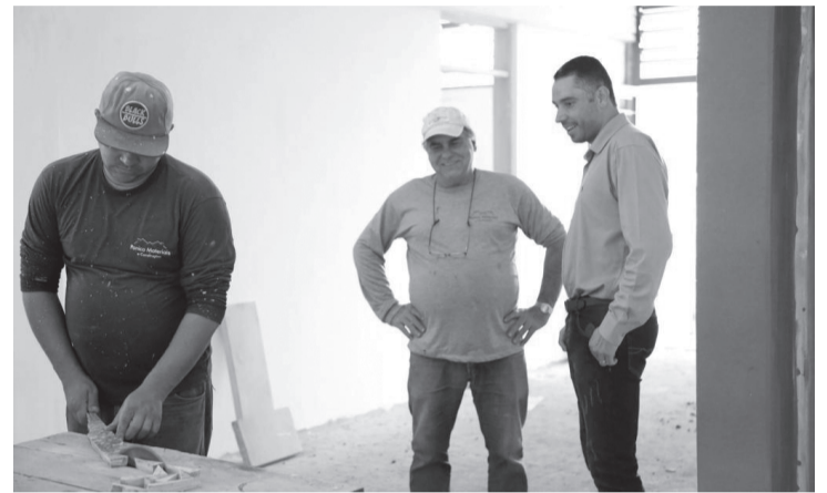
Marquinho acompanha as obras de perto
