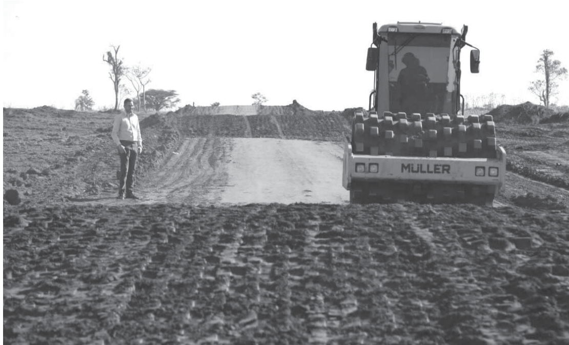
Prefeito Marquinho acompanhando as obras do Melhor Caminho
