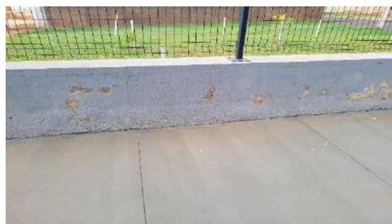
Paredes com sinais de umidade – recém-inaugurada.
